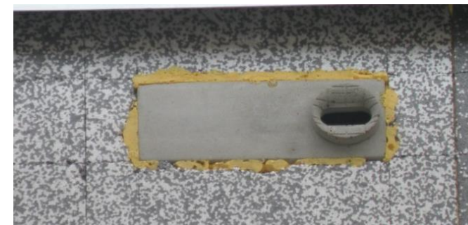
Niststein in Wärmedämmverbundsystem (WDVS) Schwegler WDV Einbaukasten Typ 1A
