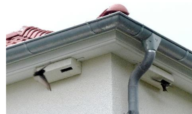
Nistkästen unter dem Dachüberstand Strobel Mauerseglernistkasten Nr. 420
