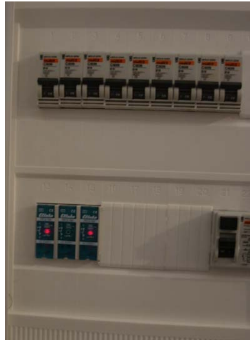
Unten links: 2 von 3 Freischalter versagten ihre Funktion
