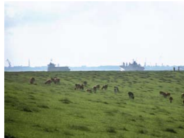
Hauptdeiche an der Flussmündung dienen dem Schutz vor Sturmfluten.
