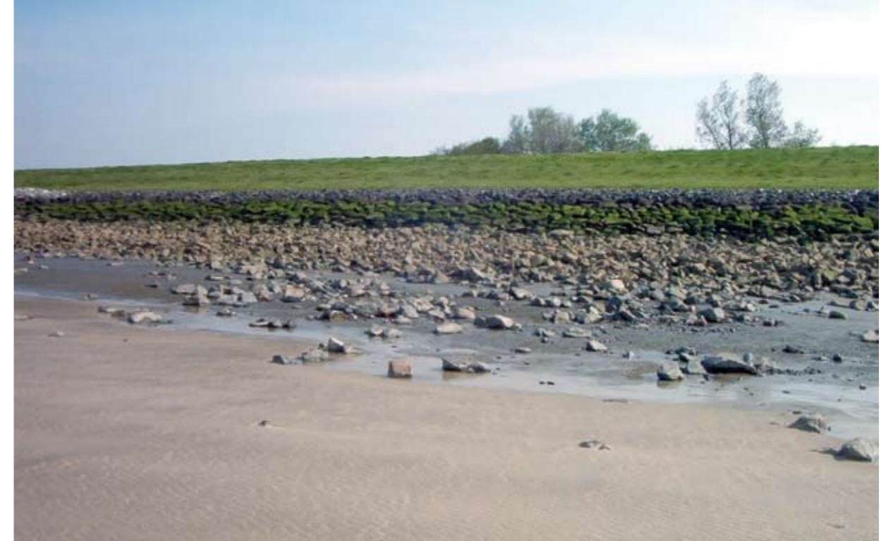
Schäden am Deckwerk eines Deiches im Altenbrucher Bogen an der Elbe.
