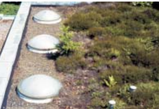
Heidevegetation als Dachbegrünung
